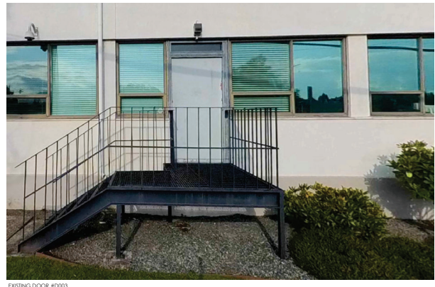
EXISTING DOOR #D003
